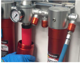
Dévisser le réservoir du filtre
