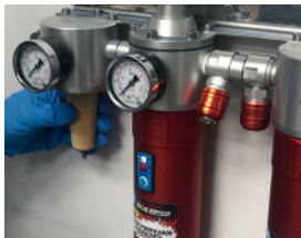
Entnehmen Sie den verbrauchten Filter
