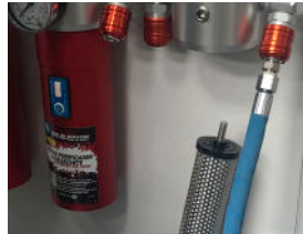
Entnehmen Sie den verbrauchten Filter
