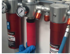
Entnehmen Sie den verbrauchten Filter
